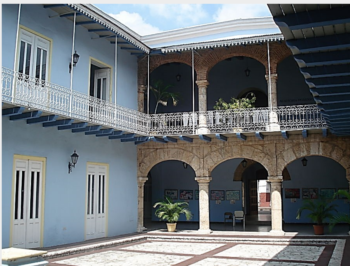
Vista interior del edificio.
